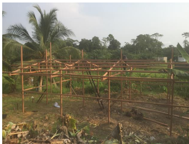
Début de construction du poulailler
